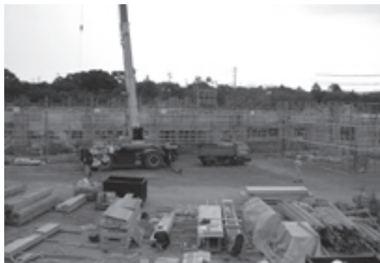
建設が進む介護老人保健施設
