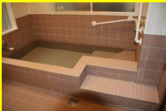
改修例(浴槽への手すり設置)
