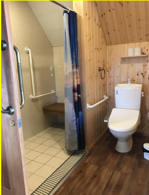
改修例(トイレへの手すり設置)
