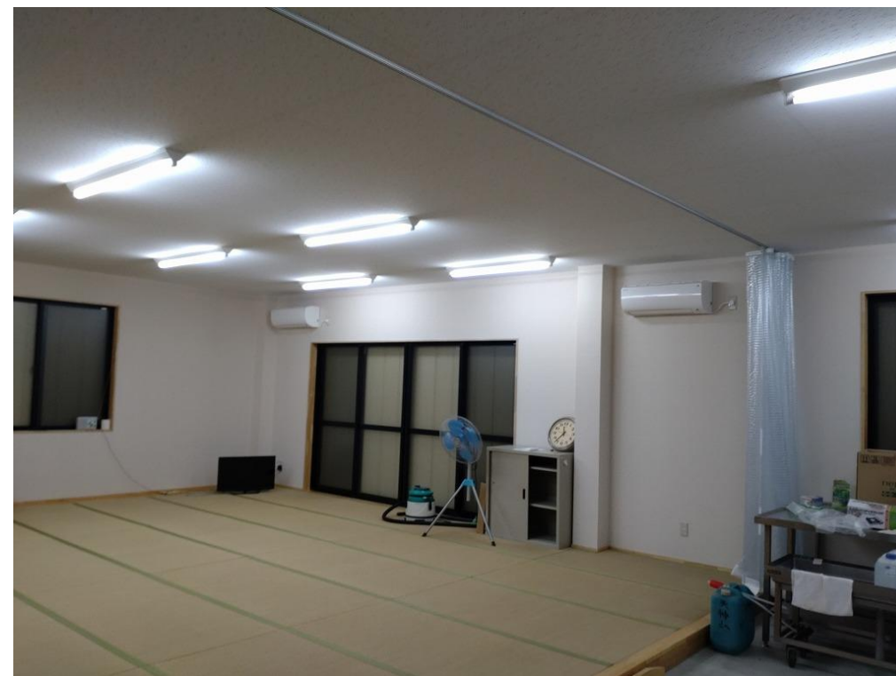
整備内容：エアコン・カーテン設置
