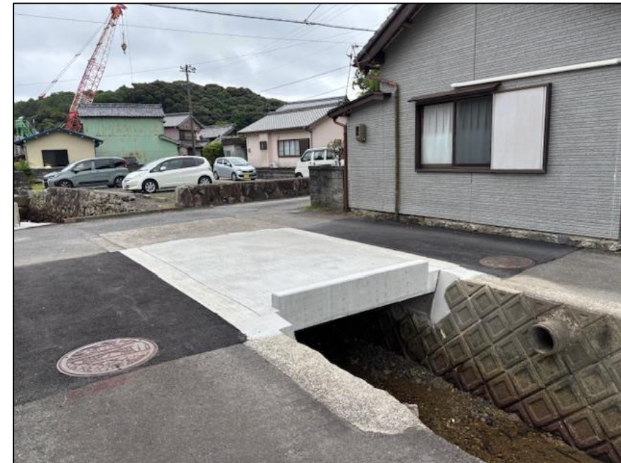
工事完成後写真
