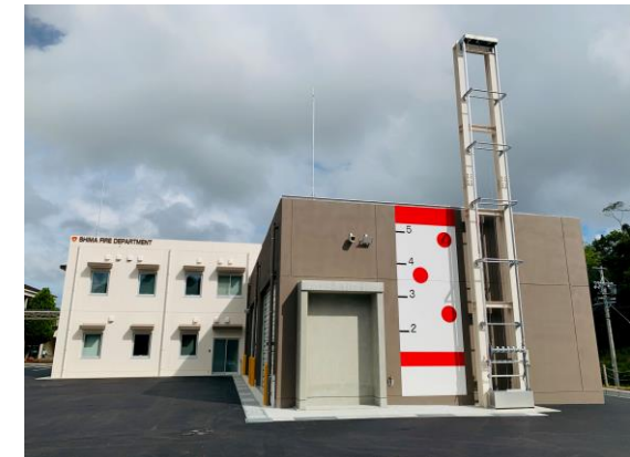
訓練用登はん壁・放水壁
