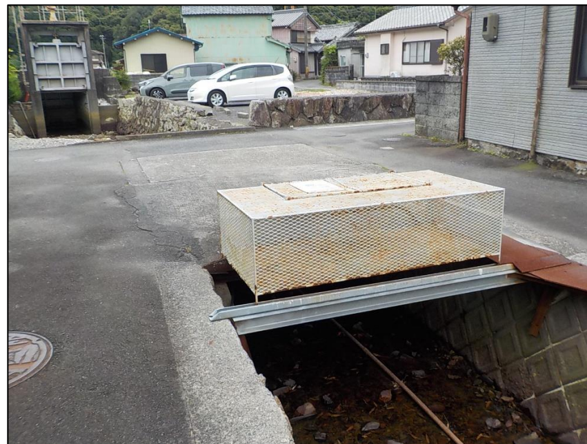
工事着手前写真
