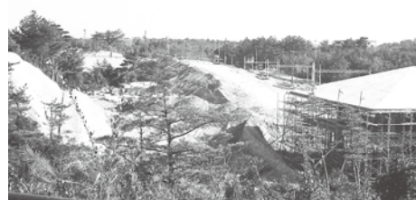
工事中の賢島駅(昭和45年)
