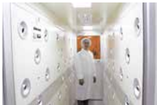
エアシャワーを通過してから工場へ
