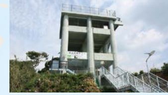
3 津波避難タワー ※市内7箇所
