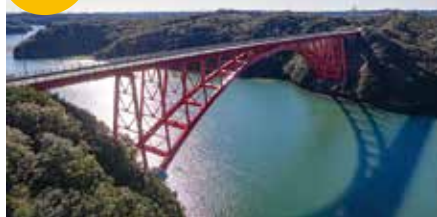
矢の矢湾大橋
