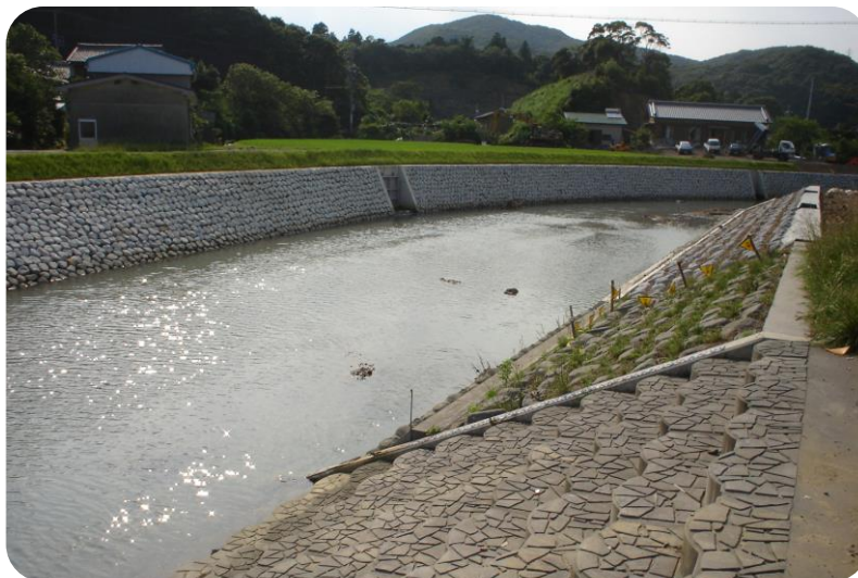
親水護岸（桧山路川）
