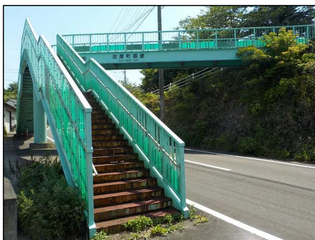
御座横断歩道橋
