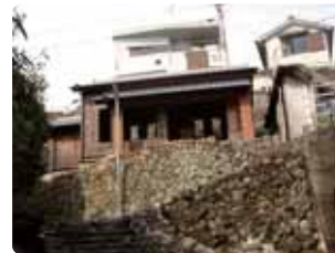
密集市街地に設置された避難所
