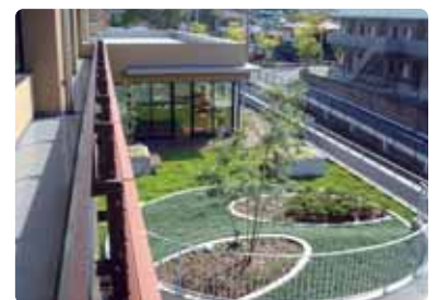
屋上緑化(市役所庁舎)
