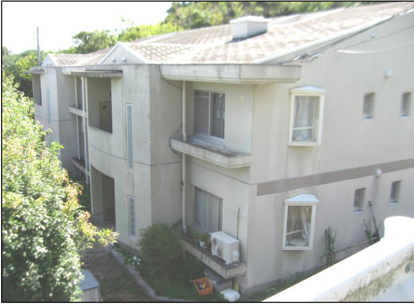
No.4 場所: 撮影日: 細田住宅
