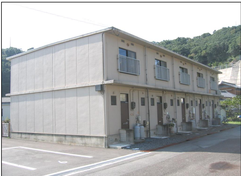
No.9 場所: 撮影日: 山田住宅 的矢住宅
