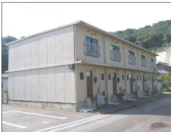
No.8 場所: 撮影日: 的矢住宅
