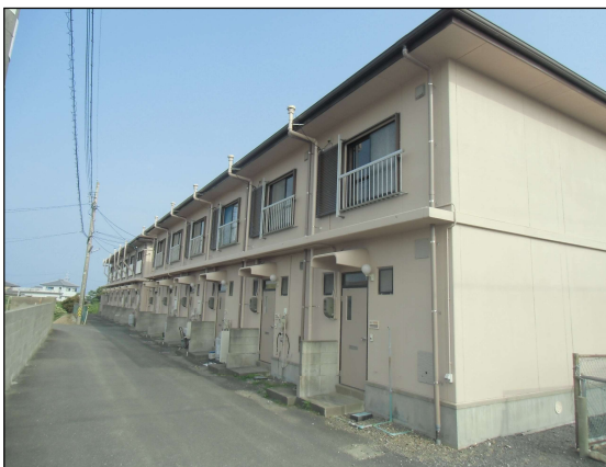
No.4 場所: 撮影日: 道筋団地
