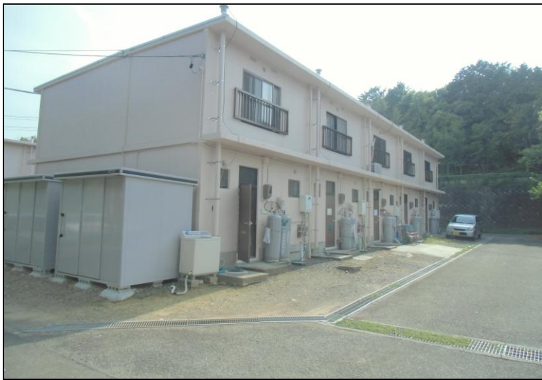
No.10. 場所：新迫間住宅
