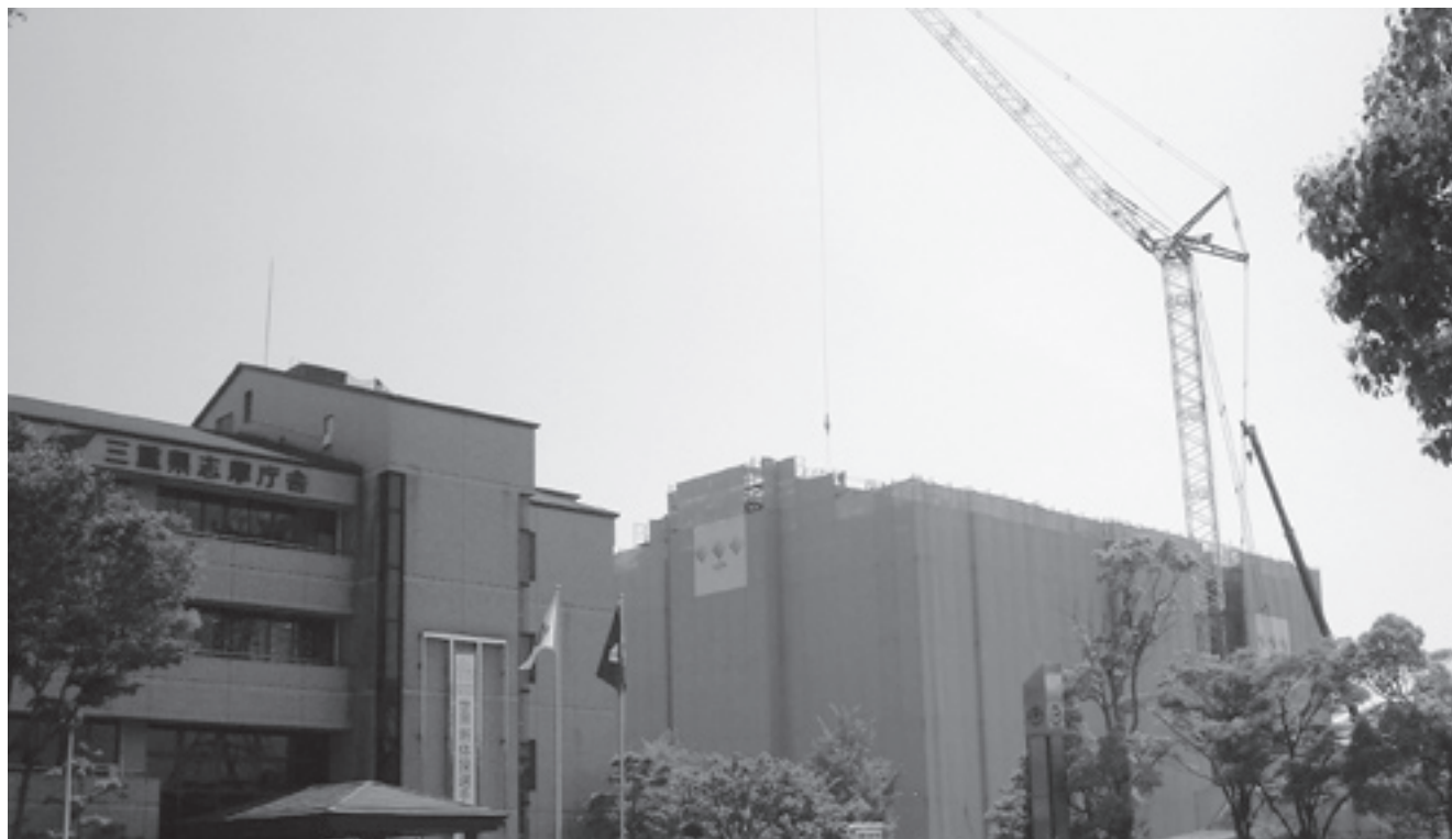
工事の進む新庁舎(右)
