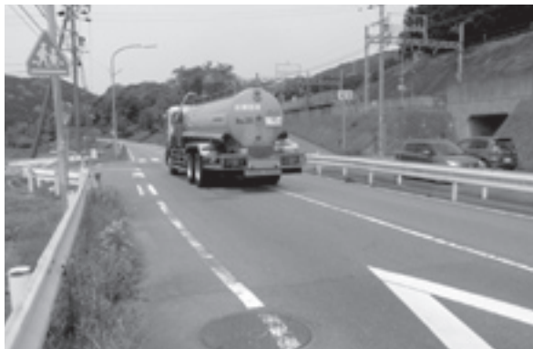
安全対策が急がれる五知地内の国道
