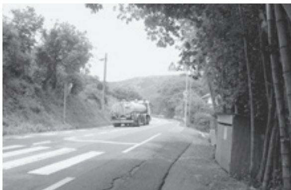
道幅が狭く危険な沓掛地内の国道
