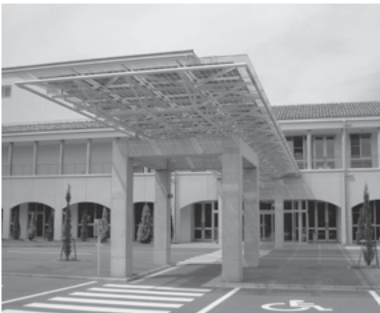
磯部支所の太陽光発電
