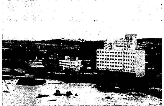
震災により閉鎖したホテル磯屋
