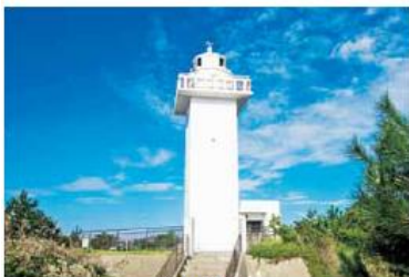
安乗埼灯台 初点灯 明治6年4月1日
