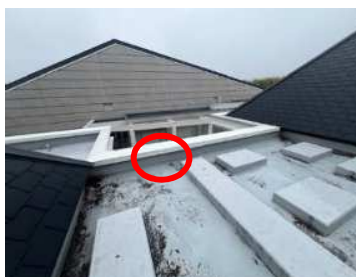
屋上（オーバーフロー管設置）
