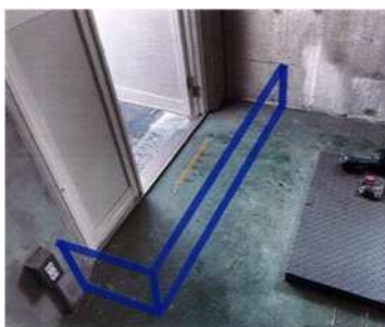
エレベーター上部（止水板設置）
