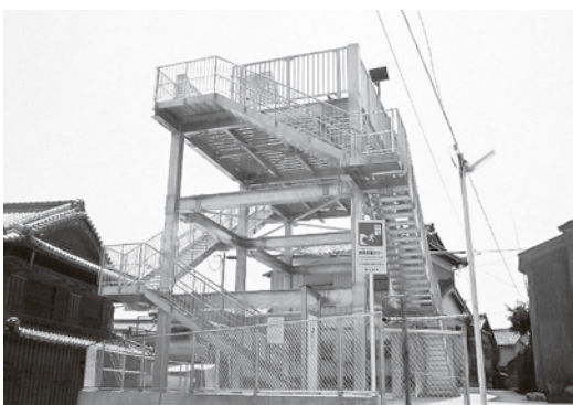
津波避難タワー
