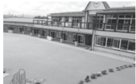
新設された鵜方保育所
