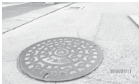
小向井地区の下水道マンホール蓋
