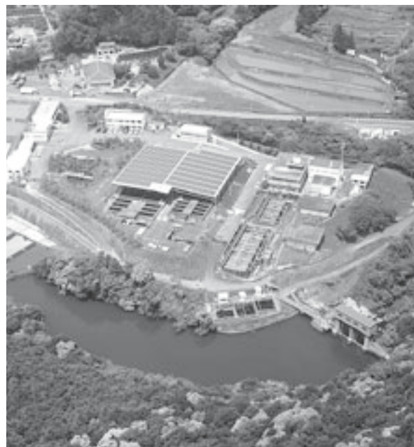
磯部浄水場の全景
