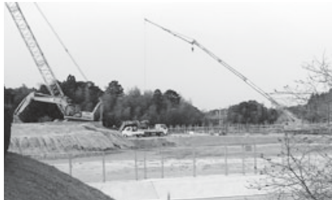
現在建設中の阿児町東部地区小学校（仮称）
