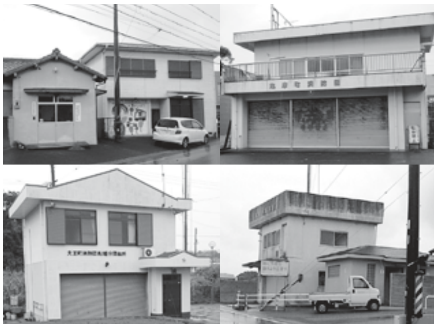
津波被害が予想される詰所の一部
