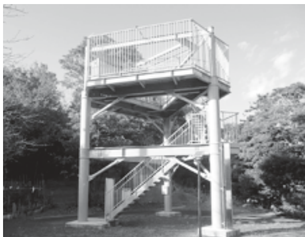
畔名地区津波避難タワー
