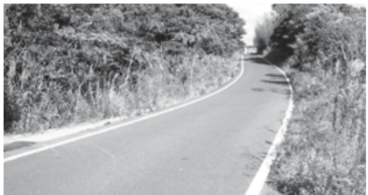
中山間事業で整備された道路
