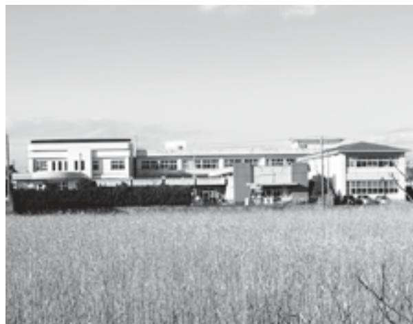
海拔5mにある甲賀小学校
