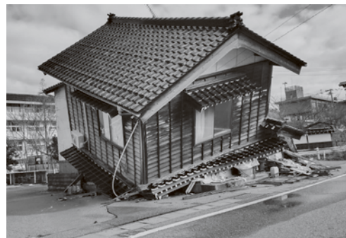
能登半島地震で倒壊した家
