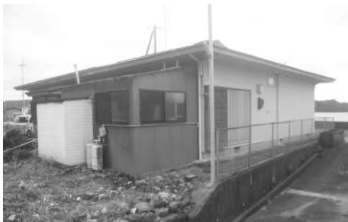
津波浸水区域に建つ飯浜集会所
