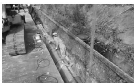
水道管耐震化工事
