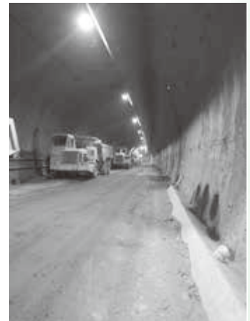
磯部バイパス（トンネル内部）
