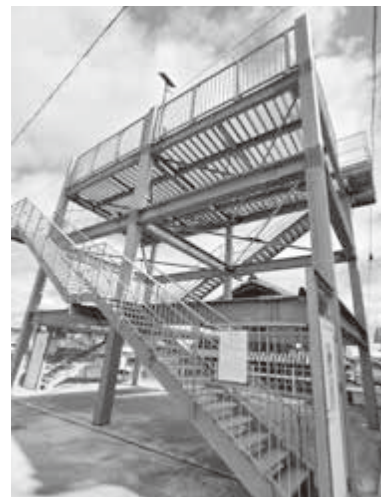
浜島津波避難タワー
