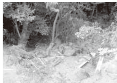
台風被害状況
