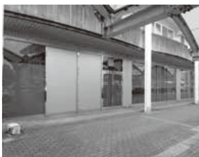
鵜方駅1階の閉鎖中トイレ
