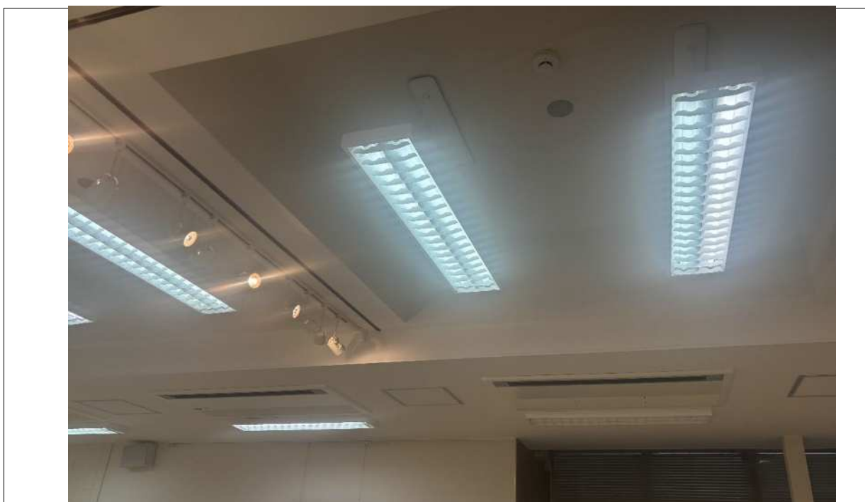
[現況写真] ①
