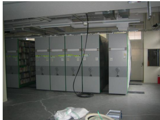
写真-4 閉架書庫据付状況
