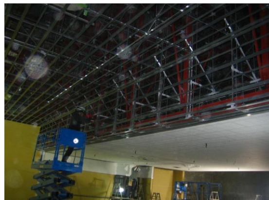
写真-6 内装改修工事状況(2)
