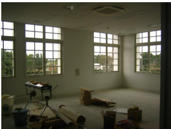
写真-5 内装改修工事状況(1)
