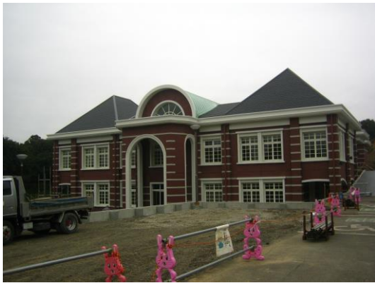
写真-1 南面側外壁仕上り状況
