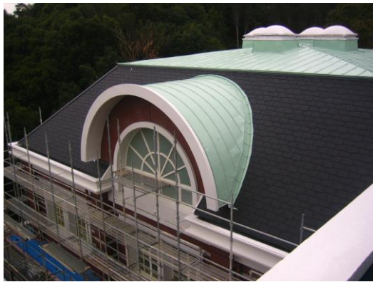
写真-3 一般開架室棟屋根改修工事状況
