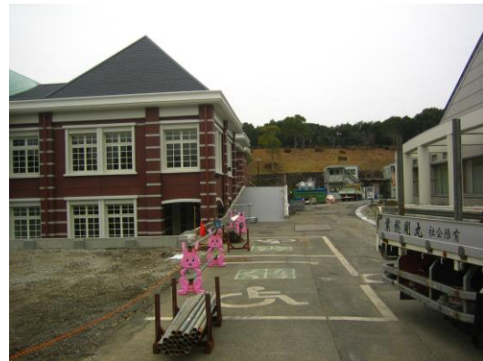
写真-2 阿児ア-十側駐車場進入路工事状況
